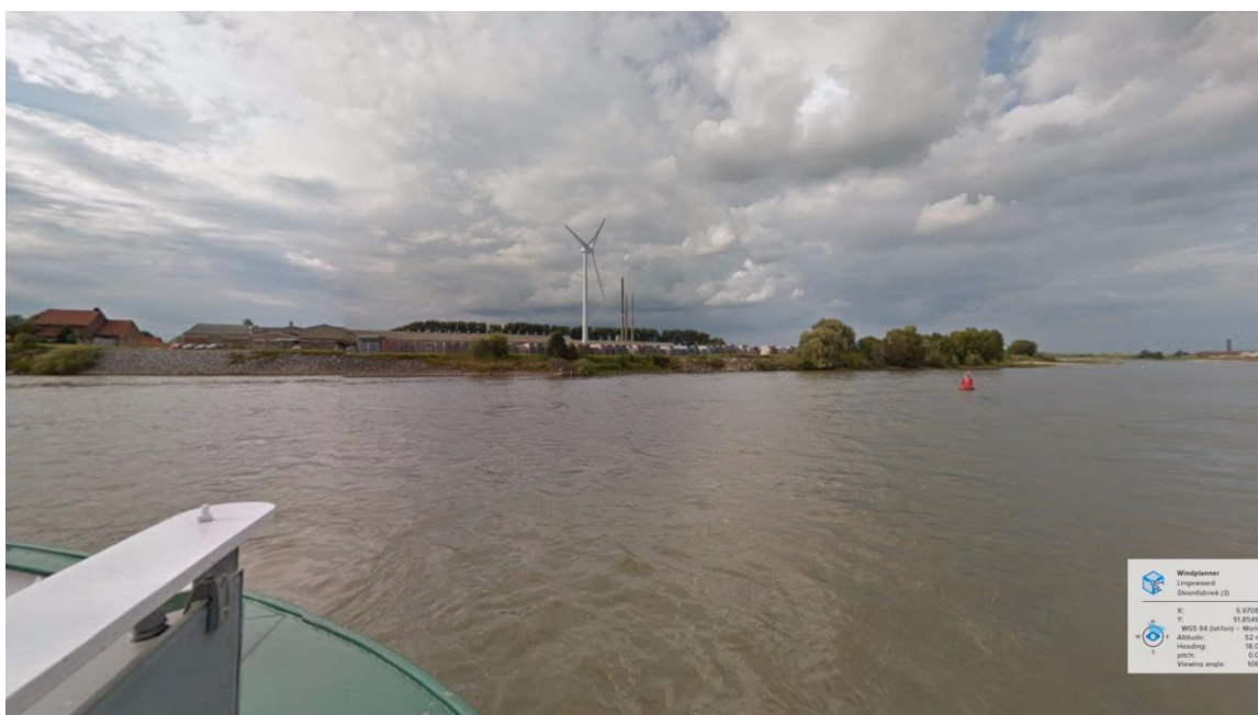
Figuur 5-24: Windturbines steenfabriek vanuit punt 8
