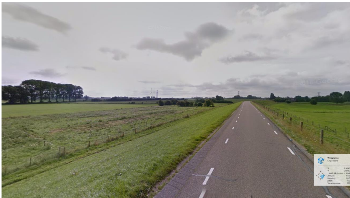
Figuur 5-19: Windturbines steenfabriek vanuit punt 3
