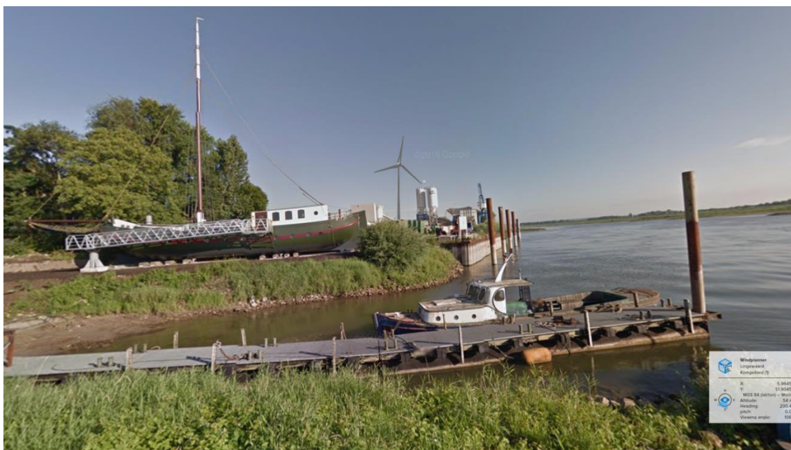
Figuur 5-18: Windturbines steenfabriek vanuit punt 2
