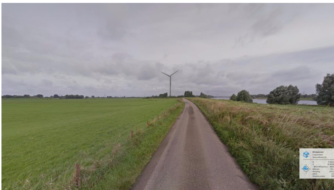
Figuur 5-20: Windturbines steenfabriek vanuit punt 4
